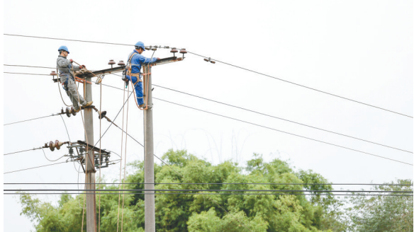
大足区珠溪镇土门村10千伏珠土线升级改造施工现场。
