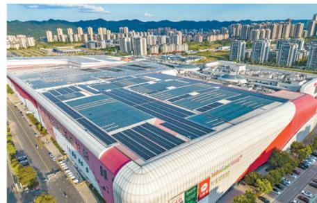
近日，沙坪坝区融创茂大型商业综合体屋顶上，分布式太阳能光伏板整齐排列，源源不断输送着绿色能源。该项目面积约5万平方米，采用发自自用、余电上网模式，接入容量3510千瓦。
