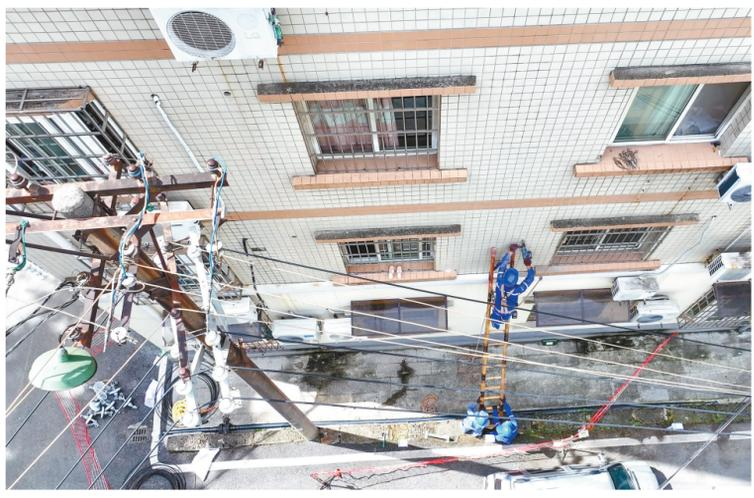
电力工人正有序更换电缆架空线路、配电箱等设施。
