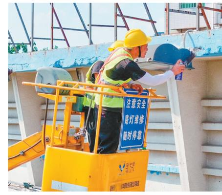
工作人员拆卸更换外墙的老化灯具。
