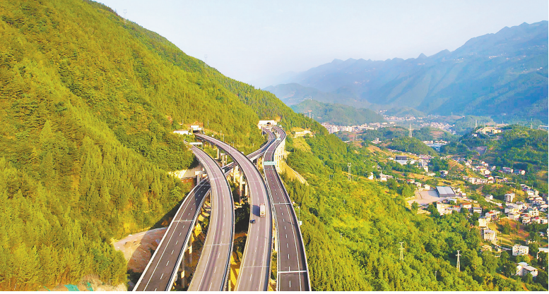
7月1日，巫云开高速巫溪枢纽至沙市互通段建成通车，标志着全长118.6公里的巫云开高速全线建成投用。图为巫溪枢纽互通。 重庆日报记者 罗斌 摄
