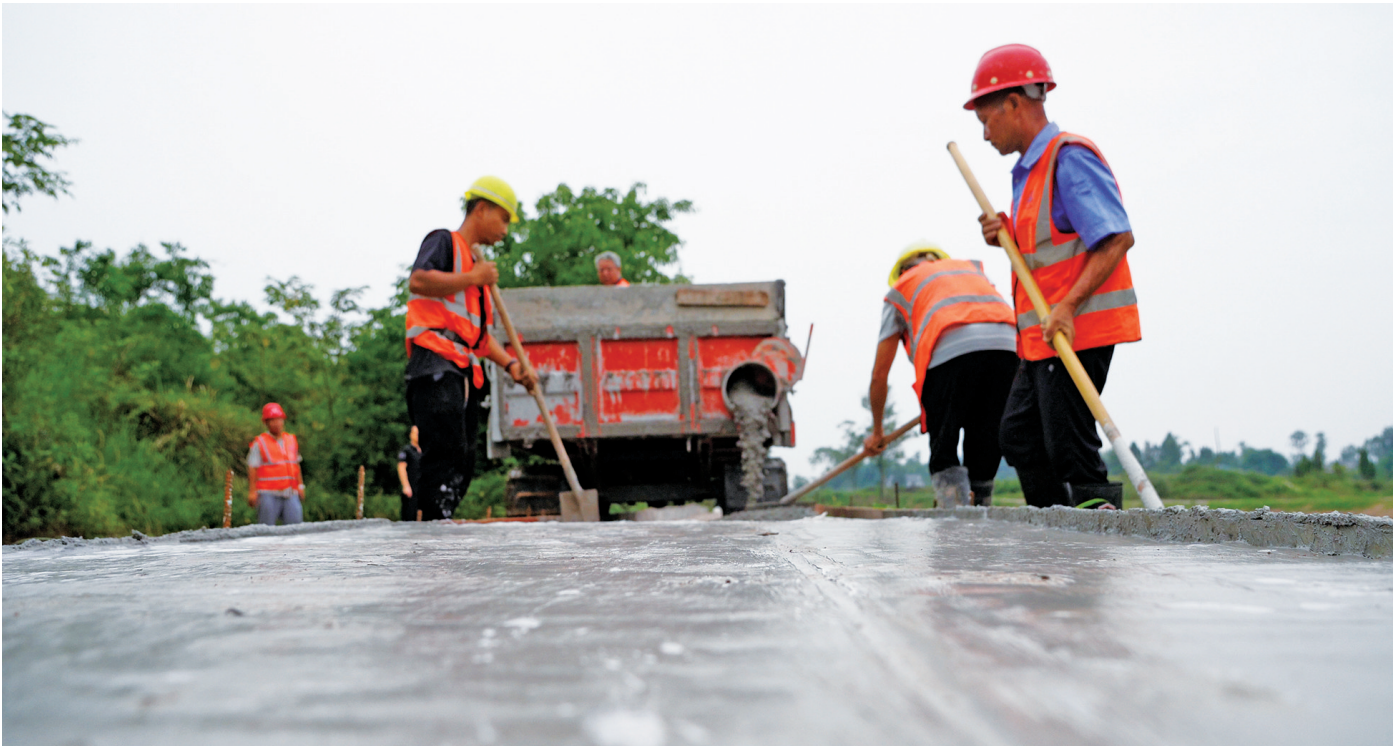
河岸步道施工现场。
