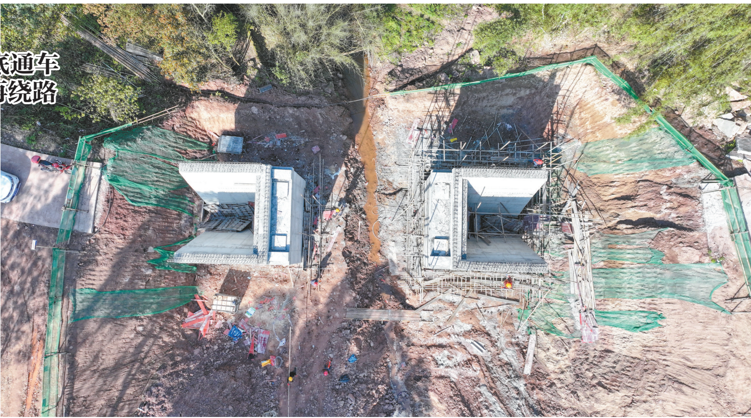
黑水凶桥重建项目施工现场。
