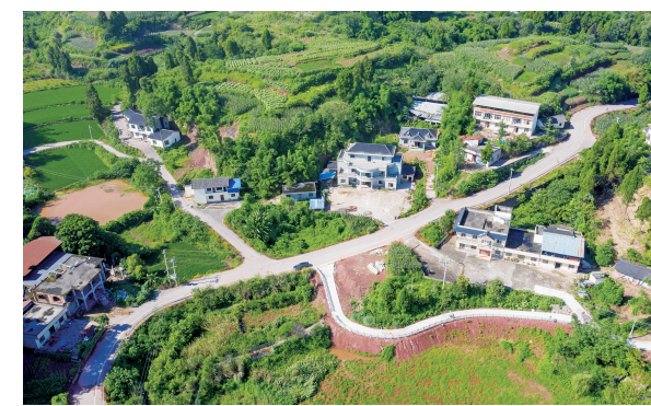
航拍下的大足区宝兴镇瓦窑村六福路，改善当地3000名村民交通条件。
