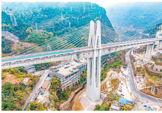
渝厦高铁重庆东至黔江段部分工程。
