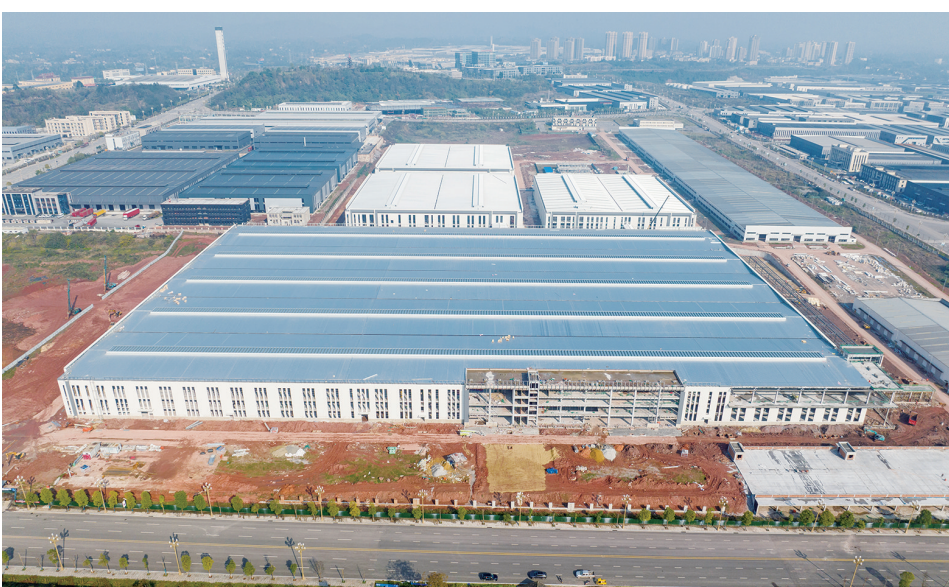
俯瞰绿源(重庆)绿色出行产业基地项目,厂房主体结构已全部完工。
