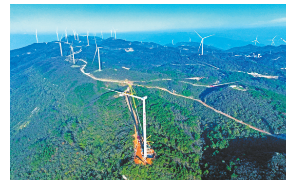
武隆四眼坪三期风电场项目施工现场。
