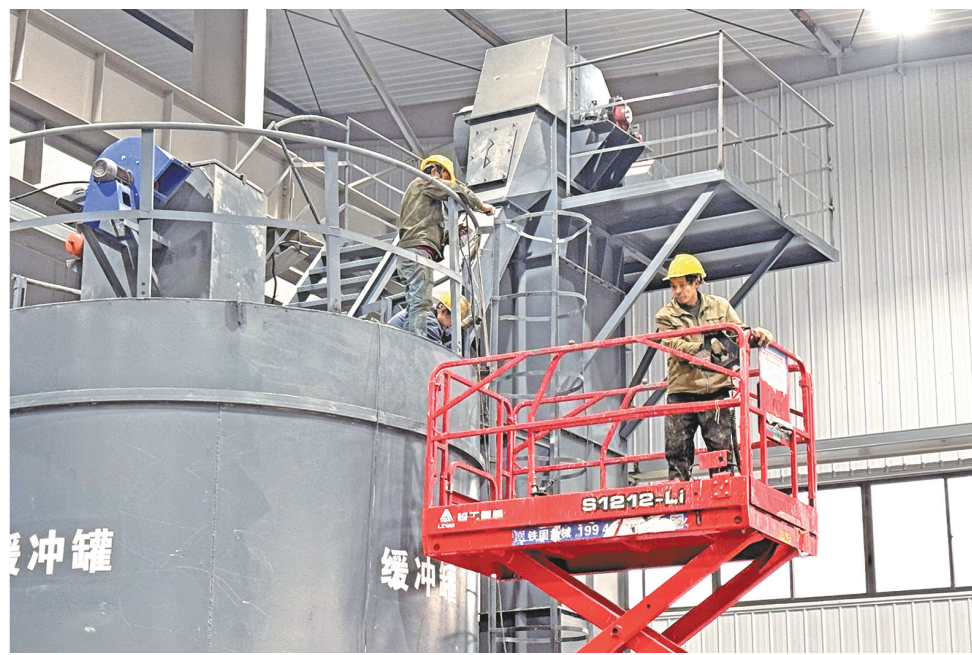
重庆旺川再生资源综合利用有限公司，工人正在安装设备。綦江日报记者 吴荣凯 摄
