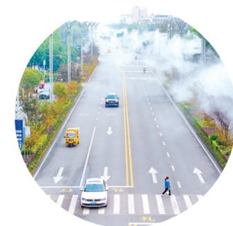
2024年11月22日，双桥经开区在城区所有主干道安装了534组路灯雾化降尘设备，水雾每隔3至5分钟从路灯灯杆喷洒而出。
