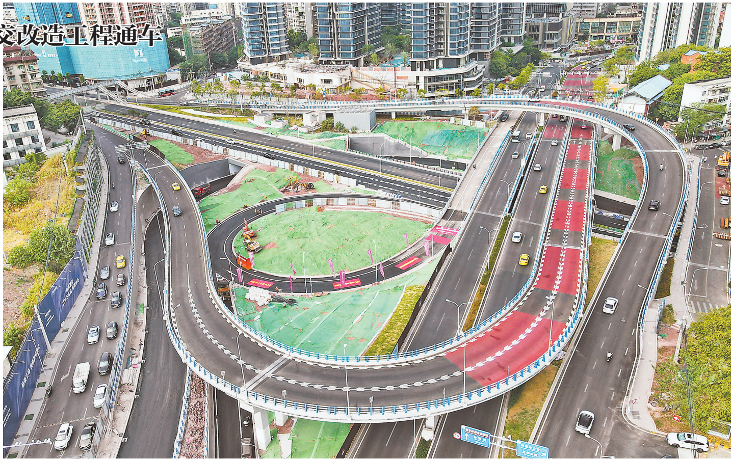
新建成的蚂蟥梁立交改造工程。(中铁二十局供图)
