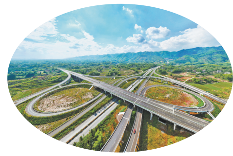
10月7日,梁平区礼让镇齐河村,重庆梁平至四川开江高速公路齐河枢纽立交桥四通八达,壮美如画。
