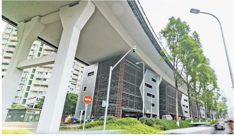
沙坪坝区石门大桥桥下机械停车库。(资料图) 重庆日报记者 李雨恒 摄
