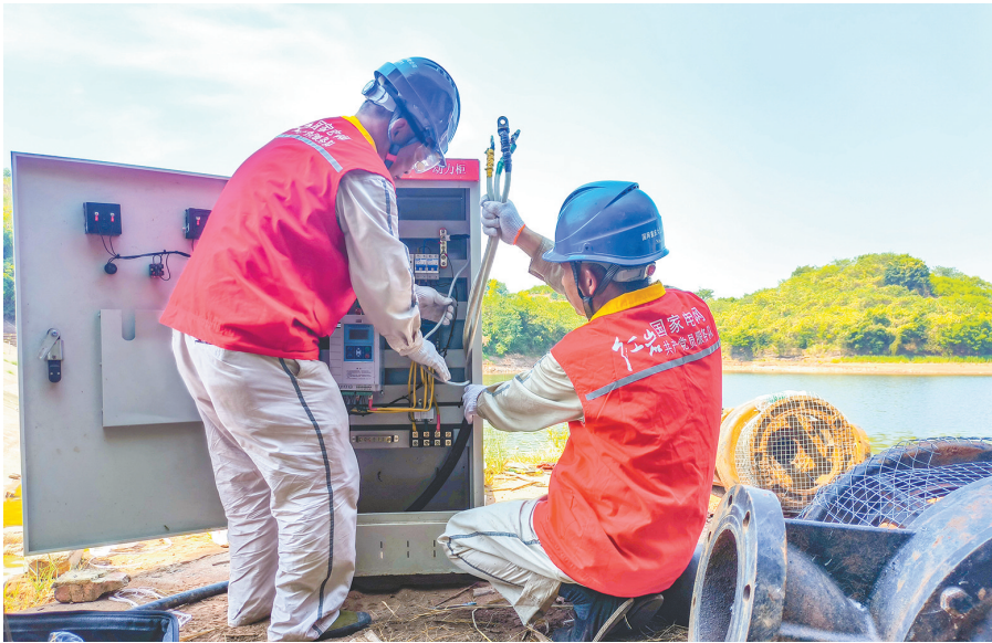
服务队队员在跃进水库为佛手基地接入临时电源。
