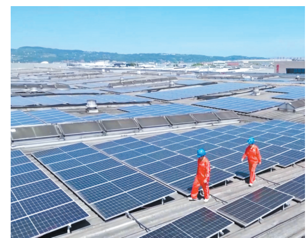
电力员工开展屋顶光伏巡检工作。
