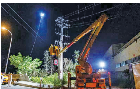
渝西不停电作业中心专业人员在大足工业园区处理电力隐患。
