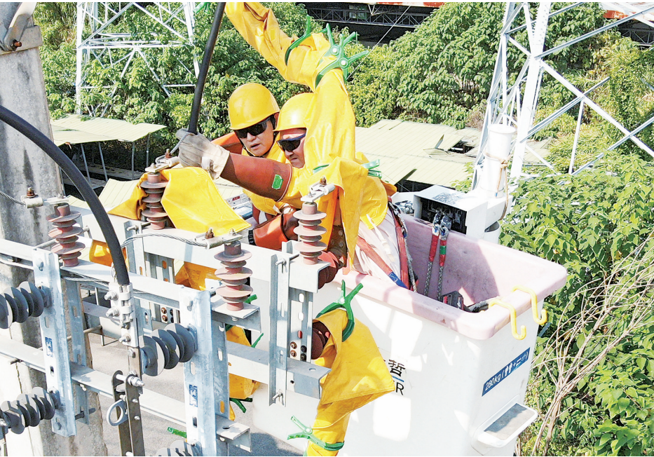
国网大足供电公司带电作业班在大足高新区龙水园区开展带电更换刀闸作业。
