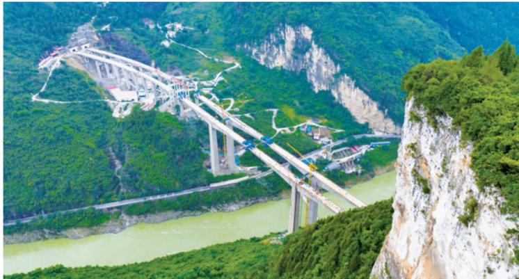
渝湘复线高速公路武(隆)道(真)路观音庙乌江特大桥连续梁右幅中跨合龙段顺利浇筑完成。
