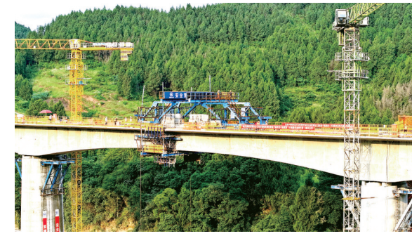
渝万高铁火地堡双线特大桥连续梁中跨顺利实现合龙
