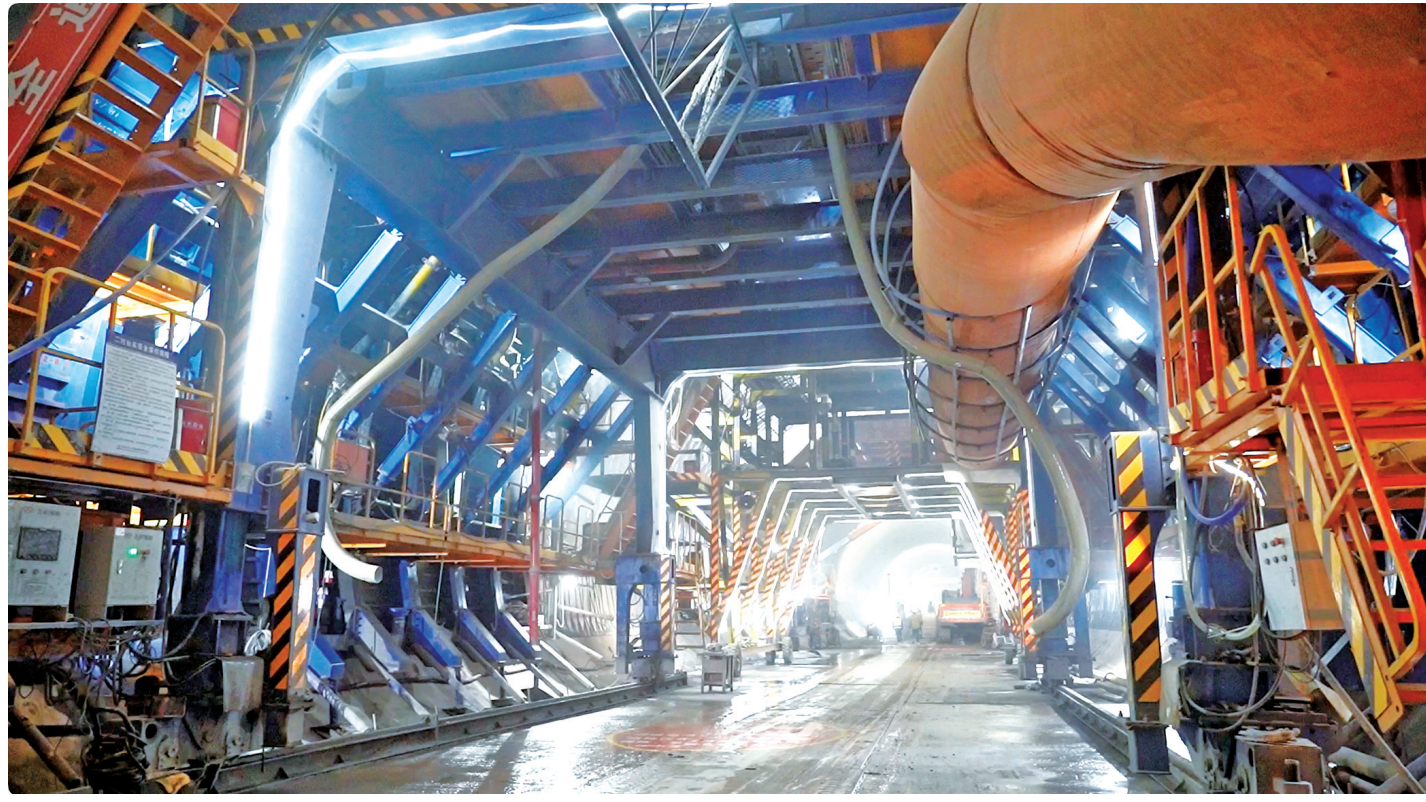
成渝中线高铁高峰村隧道建设现场。
