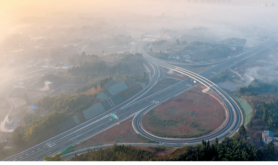
航拍下的大内高速重庆段。2023年9月15日零时,大内高速准时并入全国高速公路网,实现全线通车。大内高速将大足区到内江市的高速公路里程由现在的90公里缩短到50公里,两地车程缩短至半小时左右。(拍摄于2023年9月15日)
