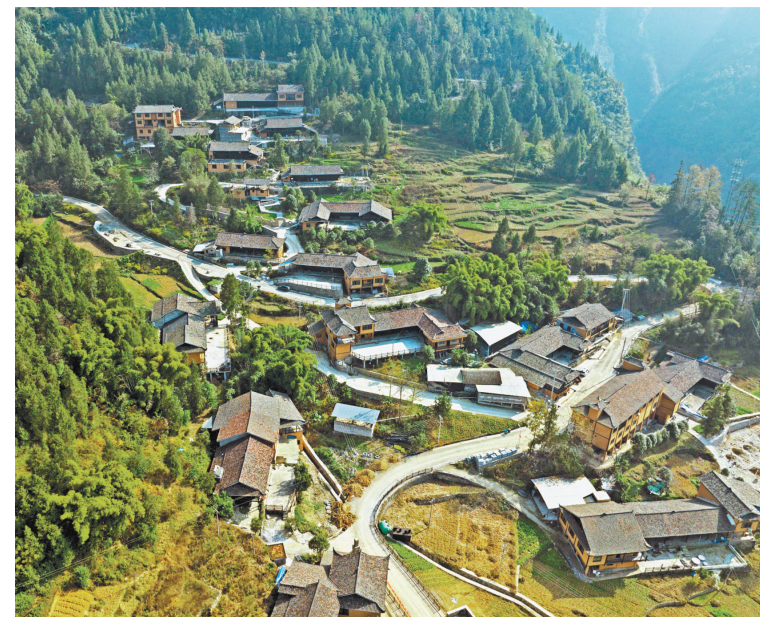
彭水县绍庆街道阿依河社区胡家湾苗寨建筑群,正在修缮改造。 重庆日报通讯员 赵勇 摄
