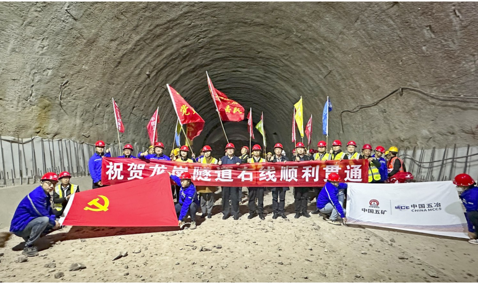
龙岗隧道右线顺利贯通。
