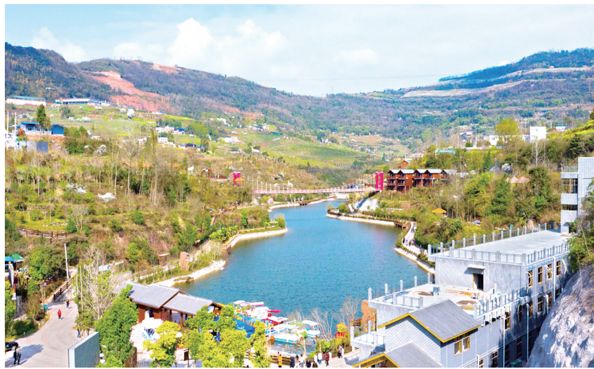
万州区长岭镇安溪村安溪谷景区。
