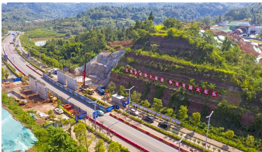
成渝中线高铁香山大道四线中桥建设现场,远处为磨盘山隧道。(无人机图片)
