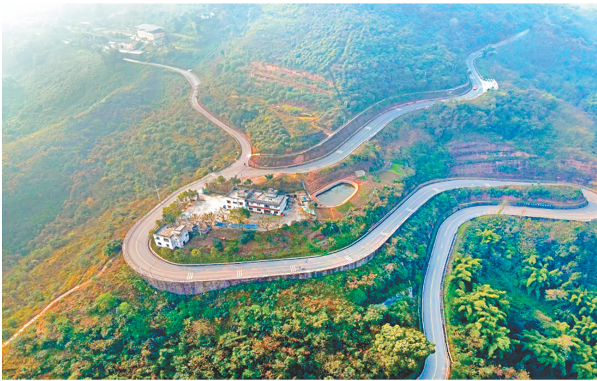
从空中俯瞰南岸区长生桥镇广福山。(图片由南岸区长生桥镇提供)
