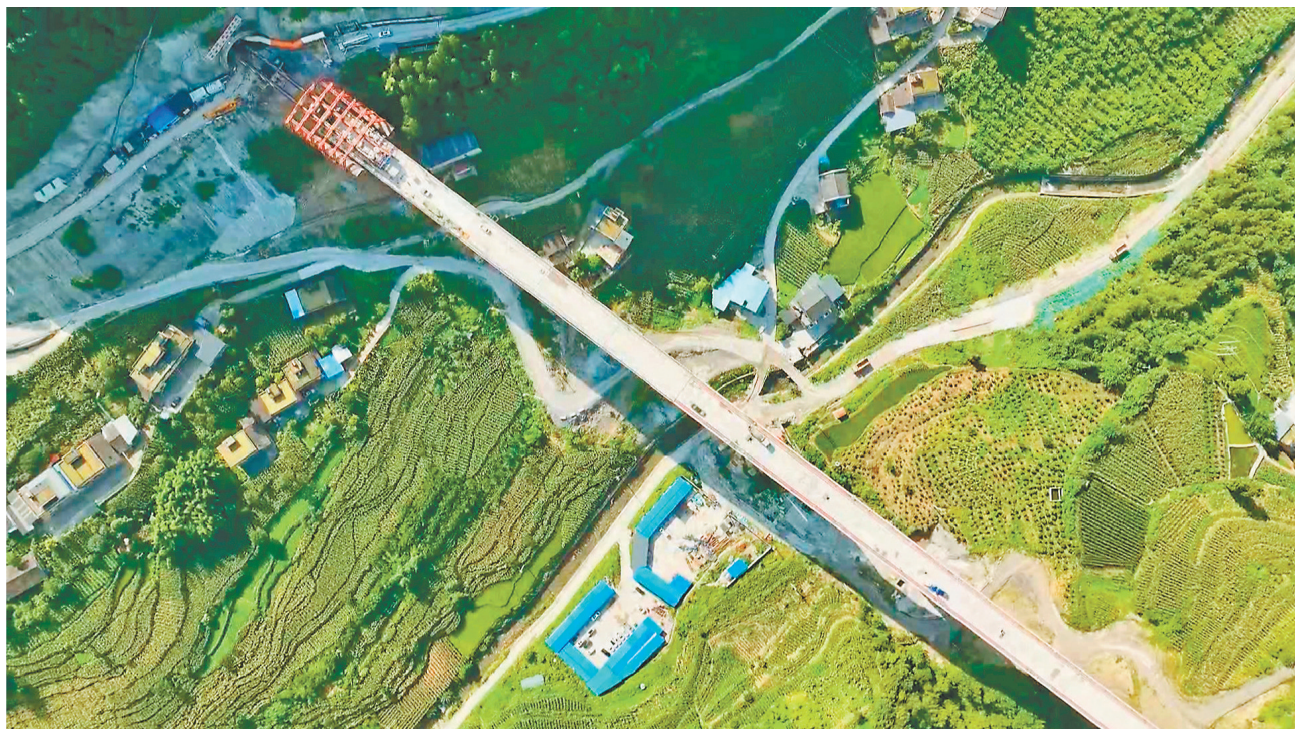
八月二日，渝湘高铁至黔江段郭家山隧道出口。(中铁七局供图)
