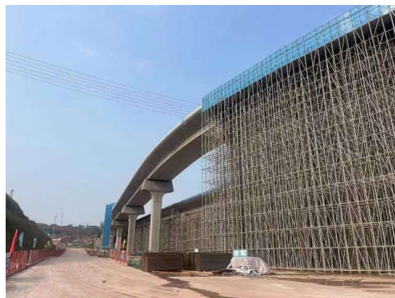
兴塘路立交段施工现场。(重庆市住房城乡建设供图)
