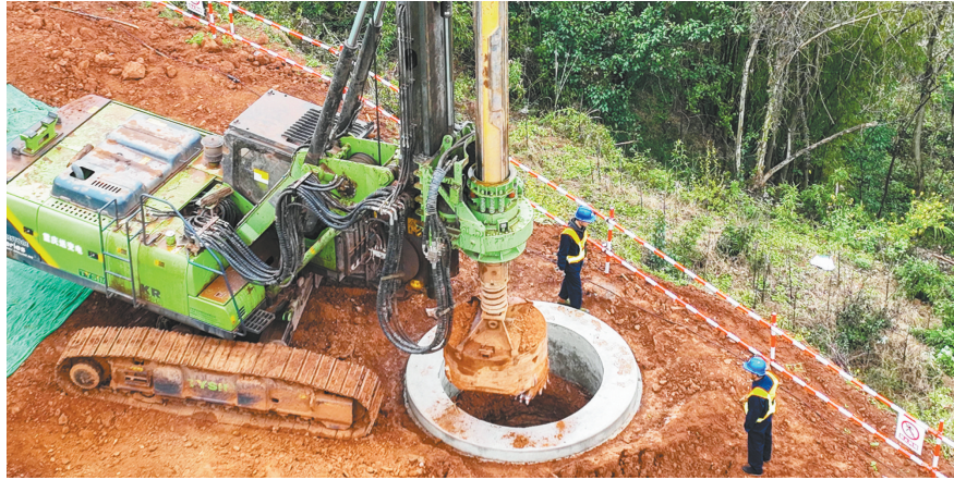
近日，在川渝1000千伏特高压交流工程(重庆段)施工现场，旋挖机正在进行基坑开挖作业。(资料图片)重庆日报记者 张锦辉 摄
