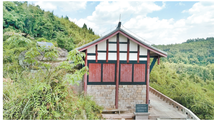
修复后的板昌沟。
