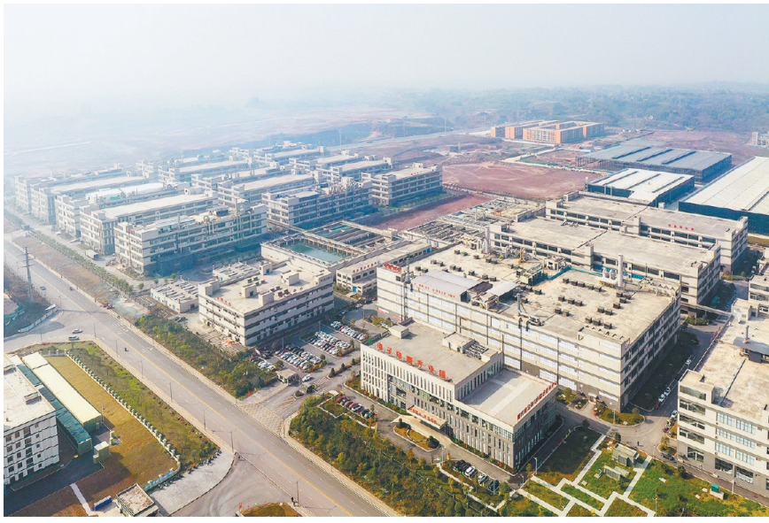
位于荣昌区的重庆电子电路产业园是川渝共建的产业园。重庆日报记者 齐岚森 摄
