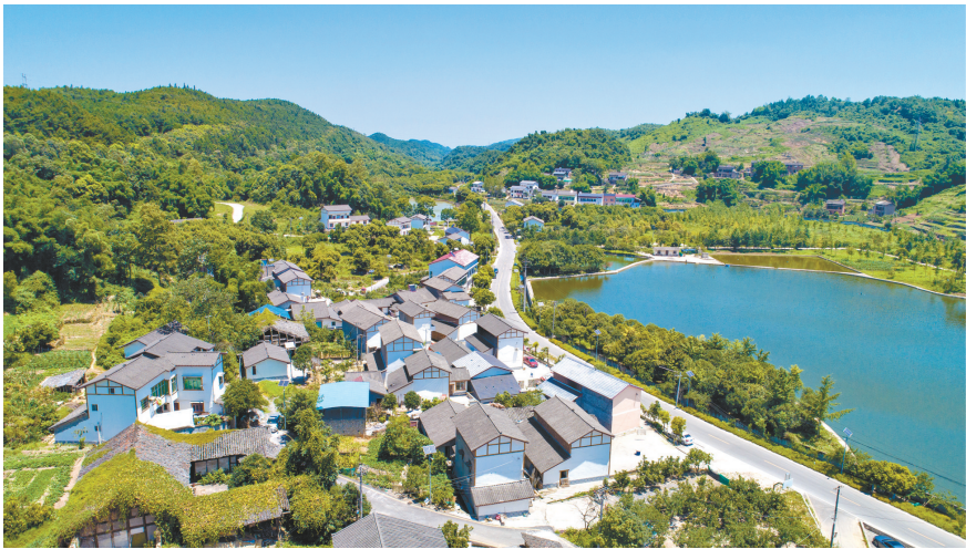
沙坪坝区中梁镇龙泉村。
