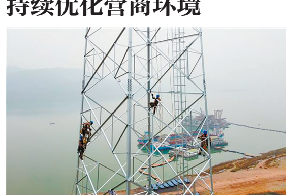
电力工人在高塔上施工作业。
