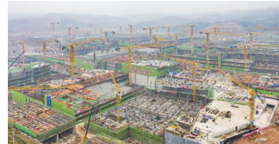
重庆东站施工现场。
