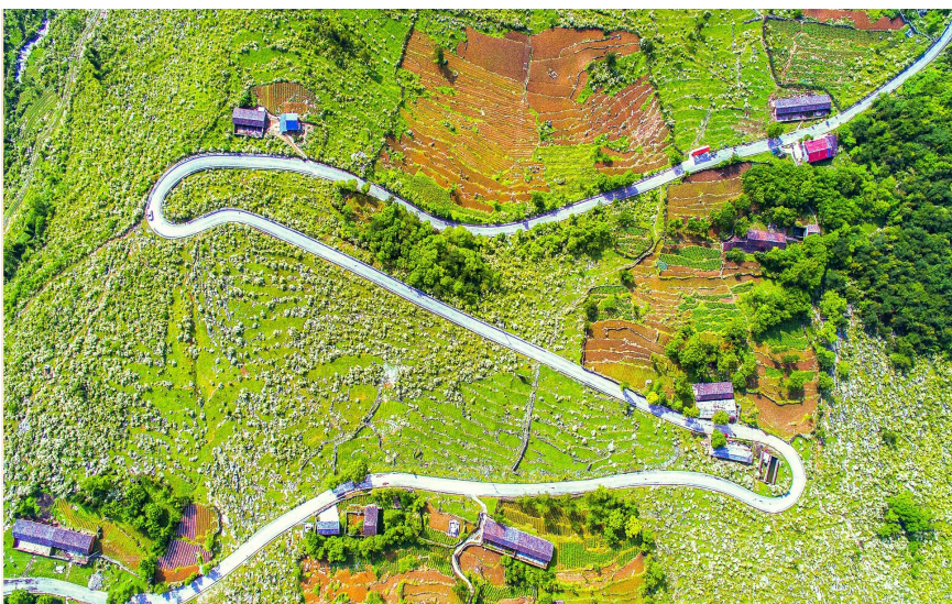
改扩建后的武太公路。
