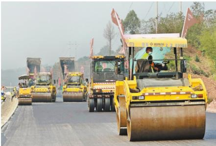
12月4日,合璧津高速公路前期通车段,中铁建技术工人正在进行沥青摊铺施工。该段全长约43公里,起于合川十塘,止于璧山七塘,预计年底通车。
