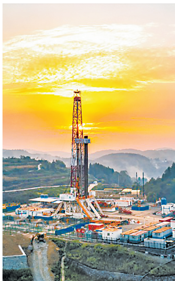
涪陵页岩气田钻井施工现场。(涪陵页岩气田供图)
