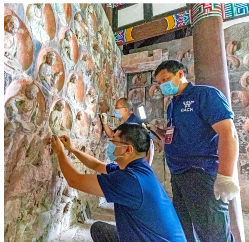
大足石刻宝顶山小佛湾,修复专家对正在对摩崖造像进行清洁。
