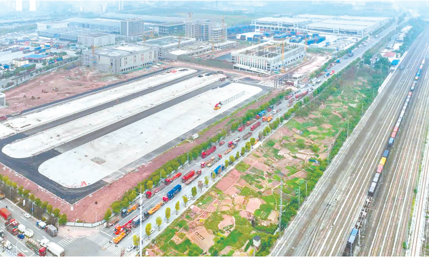
位于沙坪坝区的重庆国际物流枢纽园区正在加紧建设。重庆日报记者 张锦辉 摄
