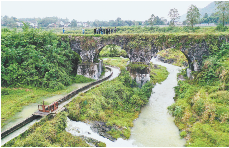
巨丰堰主渠、永丰堰主渠和泥河形成独特的水利“立交”景观。
