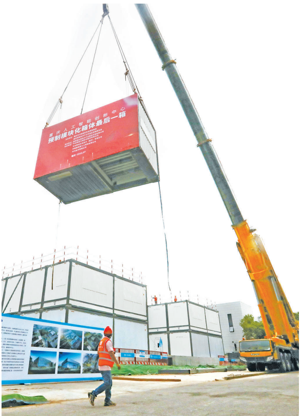
预制模块化箱体最后一箱吊装。重庆日报记者 罗斌 摄
