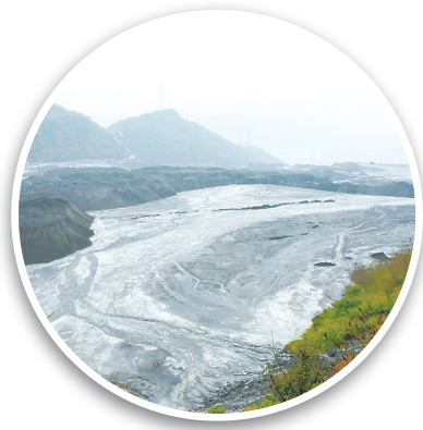
治理前的磷石膏堆场。(资料图)
